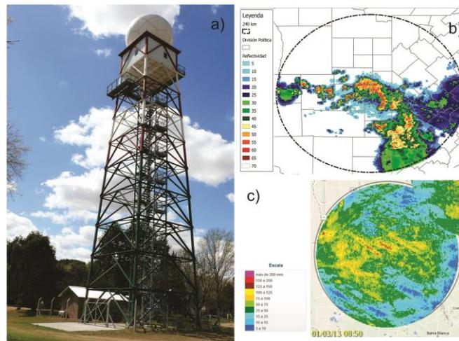
**Fig. 3.** a) Infraestructura del RM instalado en la EEA Anguil, b) Imágen de reflectividad de la primera elevación (0,5°) del 15-01-2011, 23:40hs generado con Software de INTA, c) PAC (*Precipitation Accumulation*) de Febrero de 2013 generado con Rainbow 5 de Gematronik
